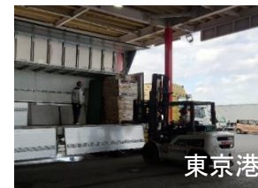
小口貨物積替施設
