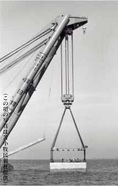
大型ケーソンの設置(昭和51年10月)
