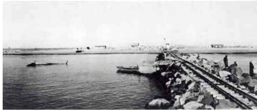
急ピッチで進められた東防波堤工事
