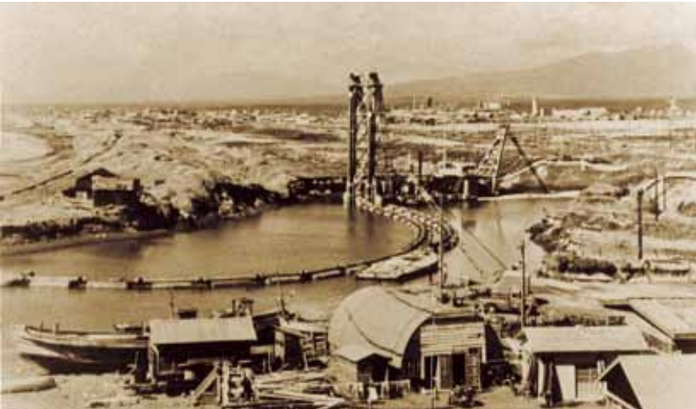
昭和35年から始まった内陸掘り込みの現場
