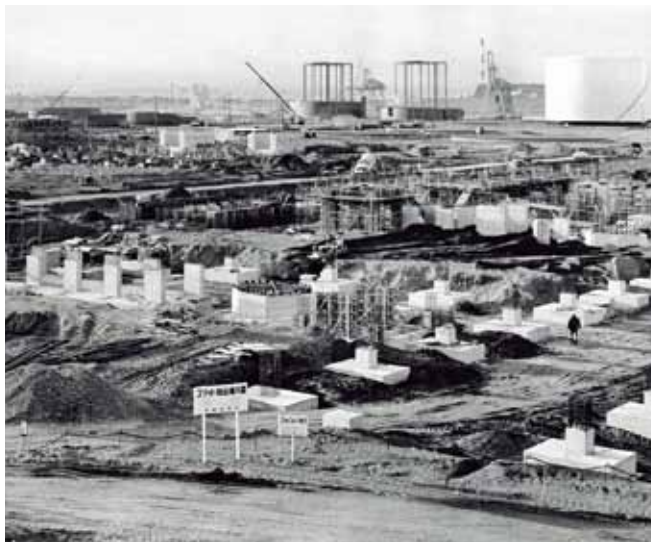
出光興産(株)北海道製油所の建設工事(昭和46年)
