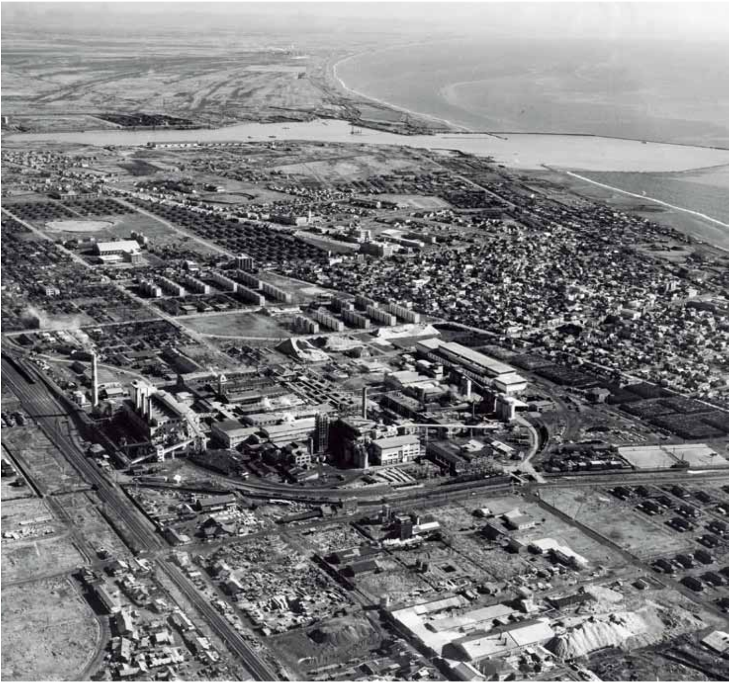
苦小牧市街地と苦小牧港(昭和38年)
