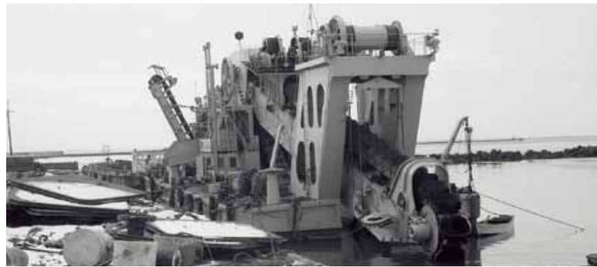
工業港区主水路の掘り込みを開始(昭和40年5月)
