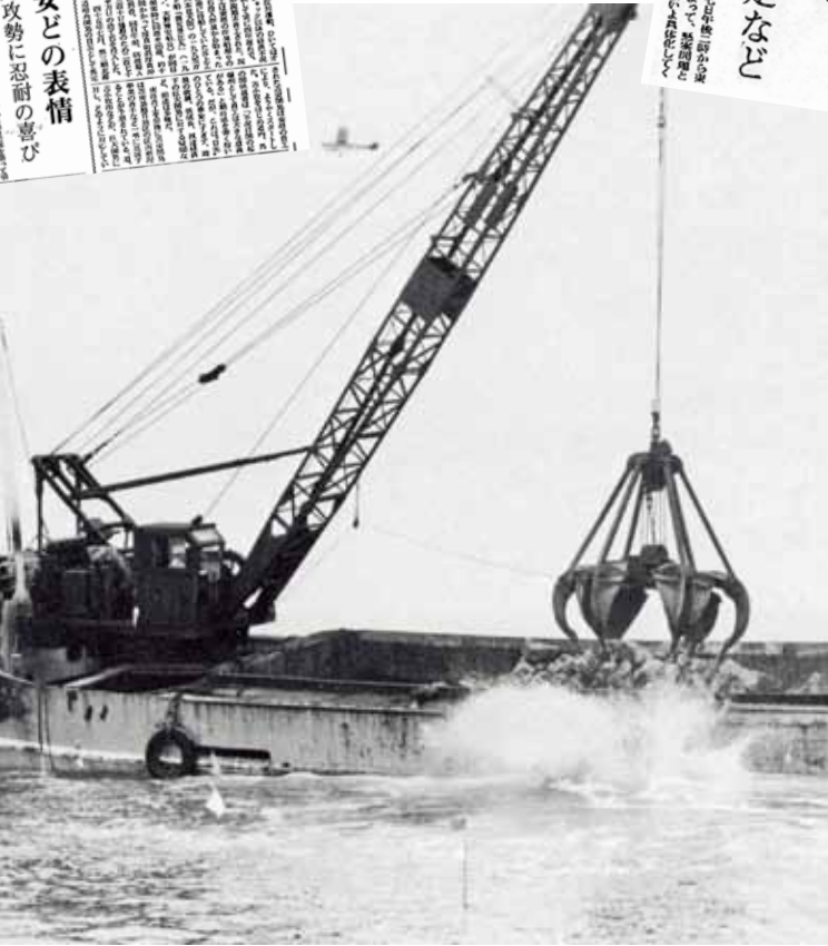
東港区着工の第一石を投入(昭和51年8月7日)
