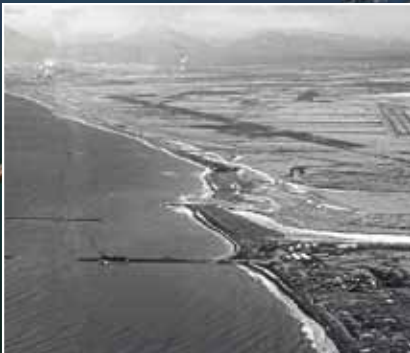
着工間もない東港区
