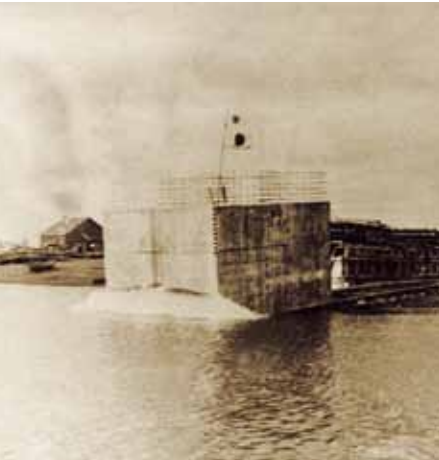
現地製造のケーソン第一号の進水(昭和31年)
