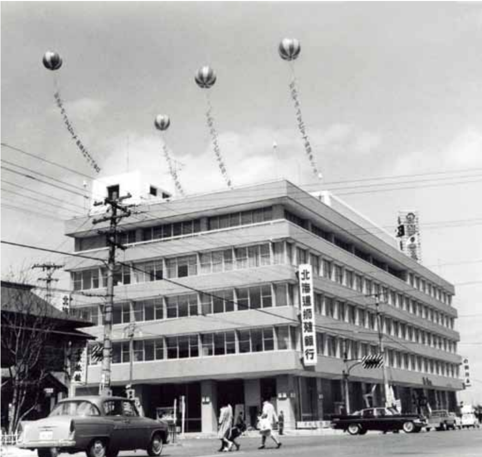
入船に向けて竣工した苦小牧ビル。祝賀会が開かれた（昭和38年4月）
