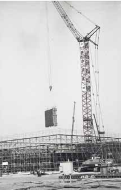
大型ケーソンの製作(昭和51年10月)
