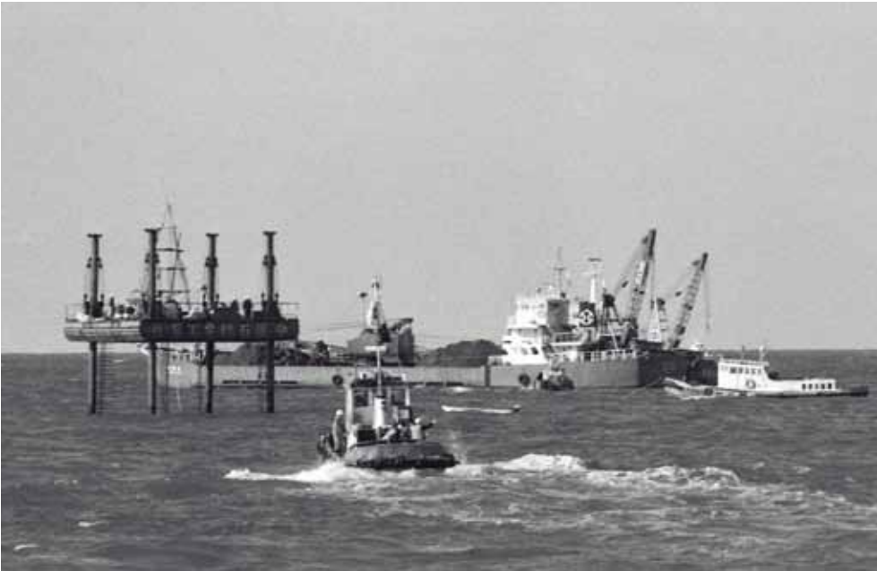
厚真町浜厚真沖の東港区着工現場(昭和51年10月)
