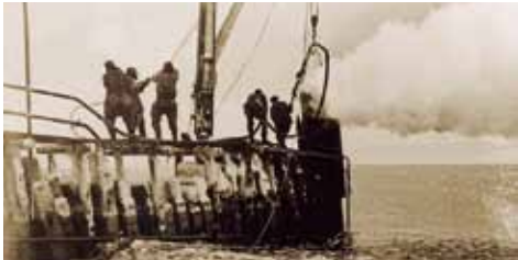
海岸での突堤工事(昭和10年)
