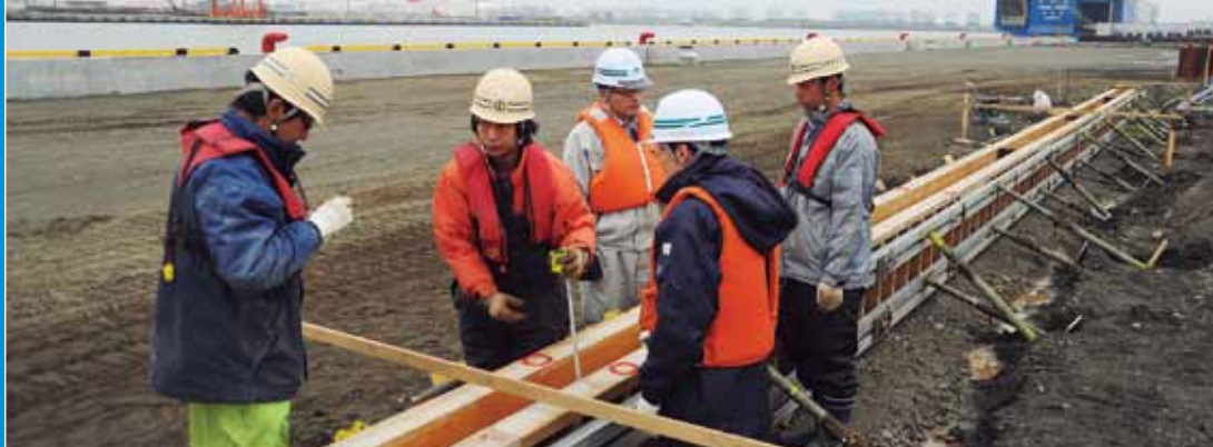
耐震強化岸壁の工事状況を検査
