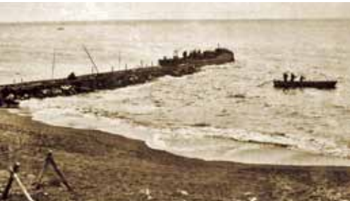
昭和27年の苫小牧港建設工事
