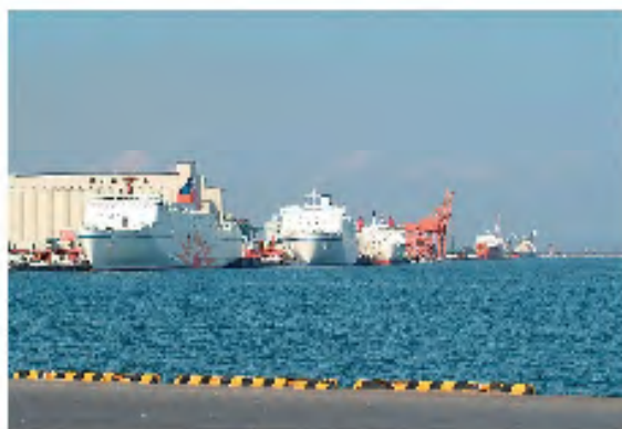
苫小牧港に寄港中のフェリー3隻
