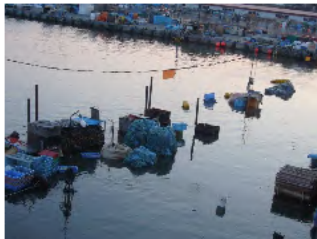
津波浸水被害を受ける岸壁
