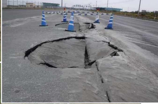
待機レーンのアスファルト舗装版陥没
