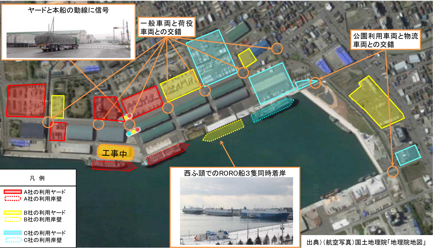
〔西ふ頭、南ふ頭における岸壁背後のヤードの点在状況〕
