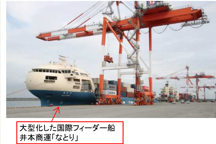
〔国際フィーダー船を含め3隻同時荷役状況〕
