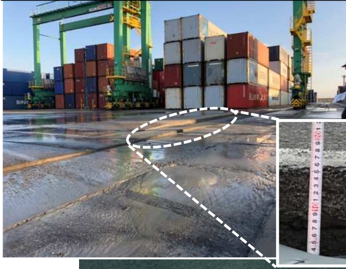
コンクリート舗装版の沈下
