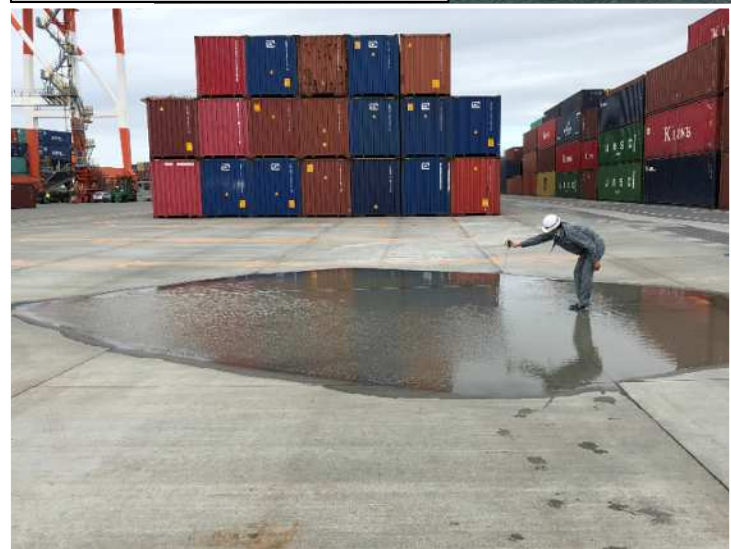
コンクリート舗装版の沈下
