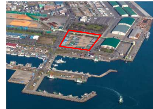
老朽化が進む 公共上屋
