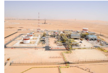
原油生産プラント(アルジェリア)
