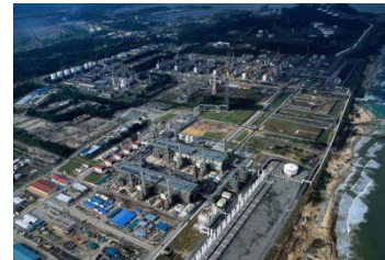
LNGプラント(マレーシア)
