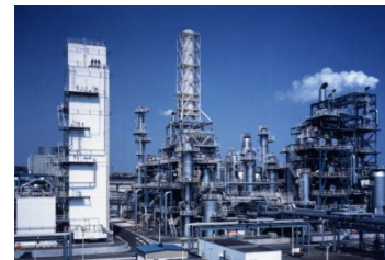
IGCCプラント(日本)
