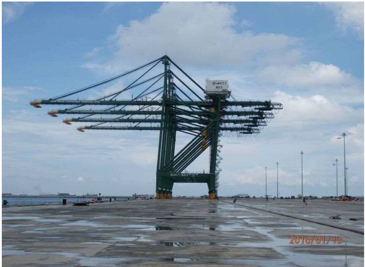
(タンジュンプリオク港 新コンテナターミナル建設現場)
