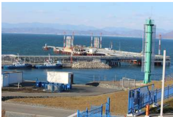
※原油の輸出設備の様子。
